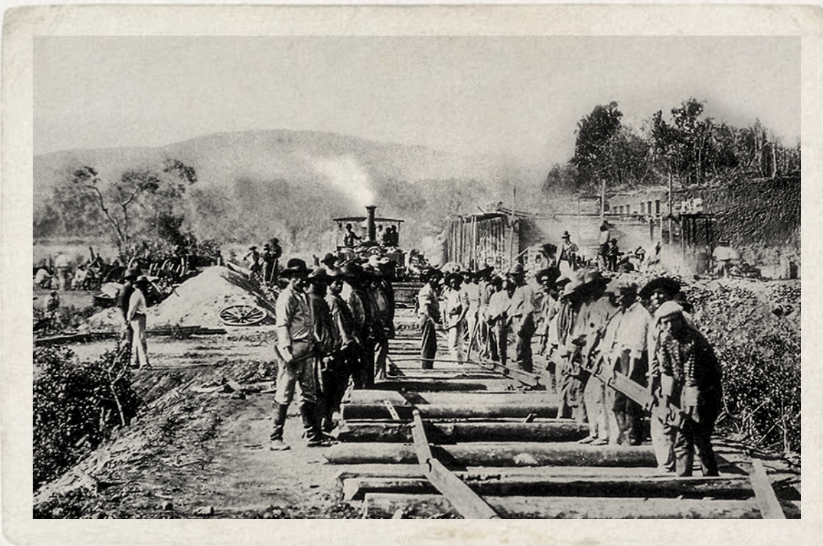
Construção da Estrada de Ferro Santos-Jundiaí
