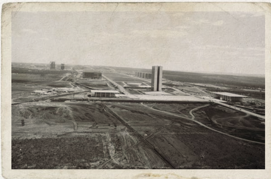
Construção de Brasília
